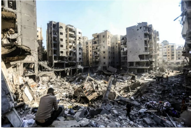
الصورة رقم 2. تدمير الضاحية. المصدر جيتي إيماجيس
