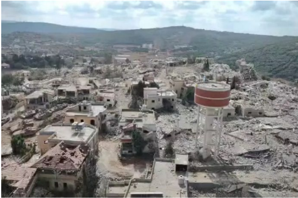
الصورة رقم 9: بلدة عيتا الشعب، حيث يظهر دمار كبير حول خزان المياه. المصدر: مواقع التواصل الاجتماعي
